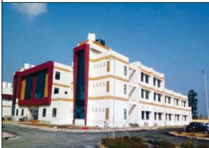
Rohtak: Site overview
